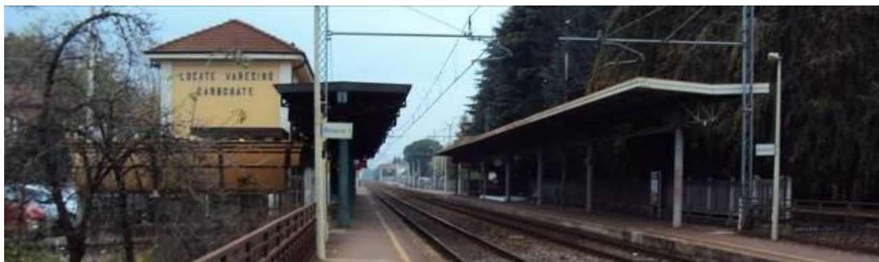
Fig. 17 - Stazione linea F.N.M. Locate Varesino – Carbonate.
